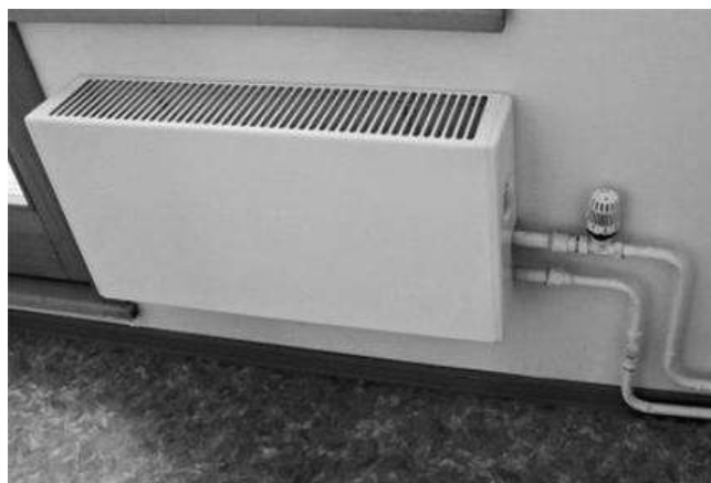
Рис. 7 – Один из элементов параллельной системы отопительного контура
